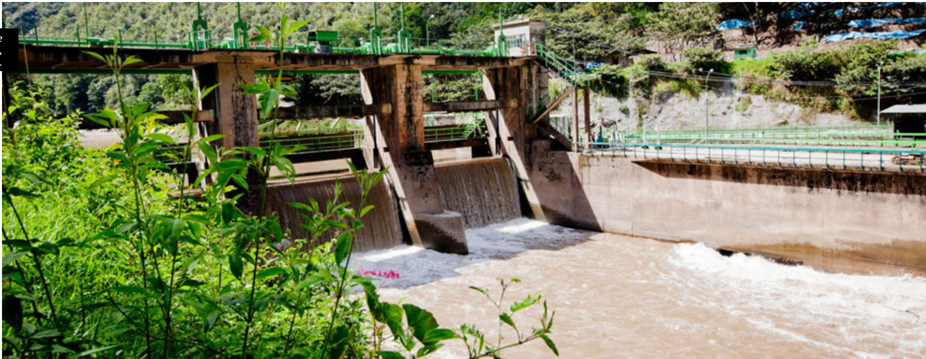
Central Hidroeléctrica de Machu Picchu, Cusco - Perú.
