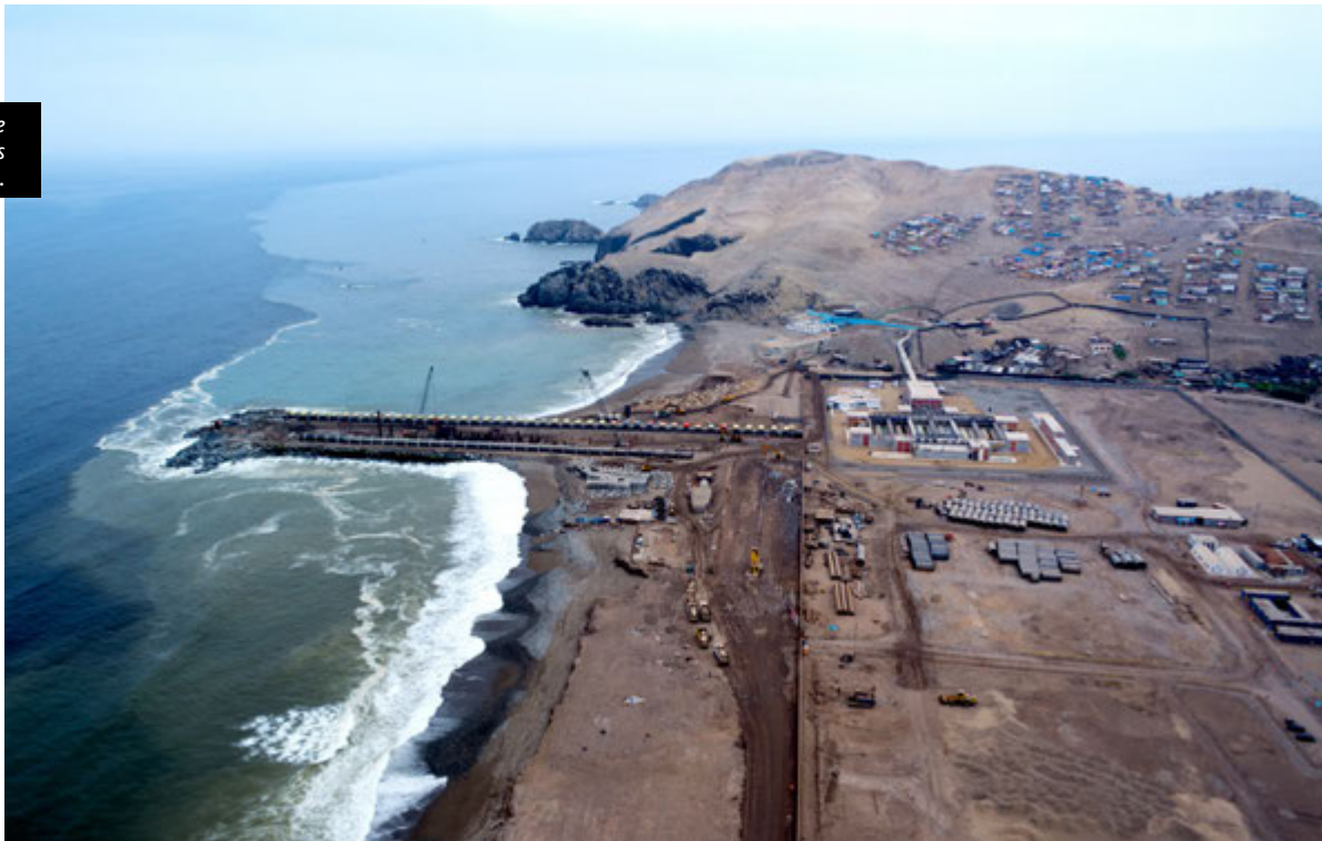
Planta de tratamiento de aguas residuales La Chira, Lima - Perú.
